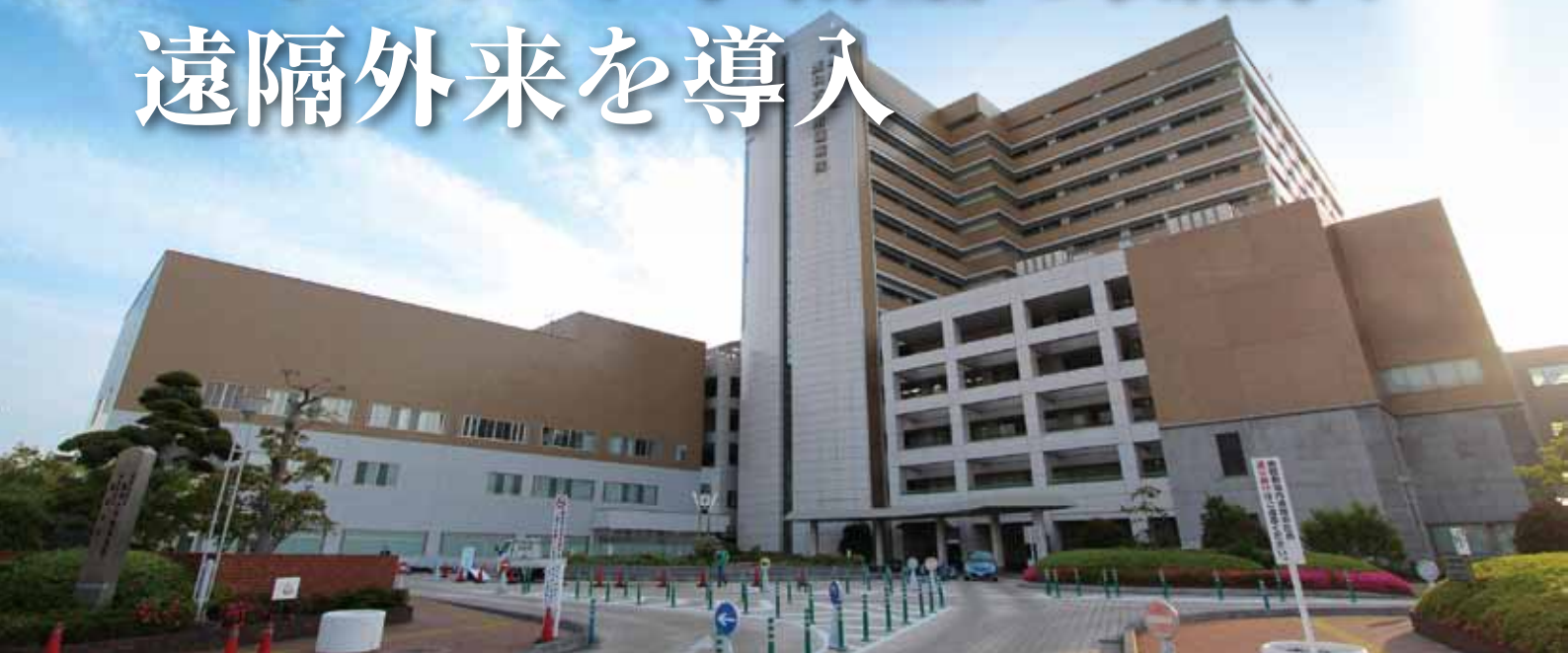
新設した東棟外観(左)
